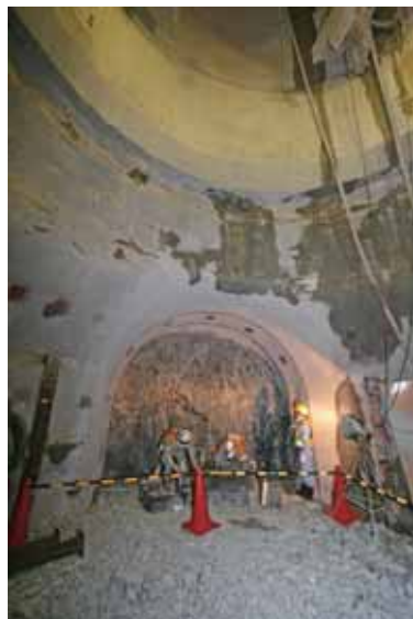
深度400m予備ステージ 入口部分の掘削（主立坑）
